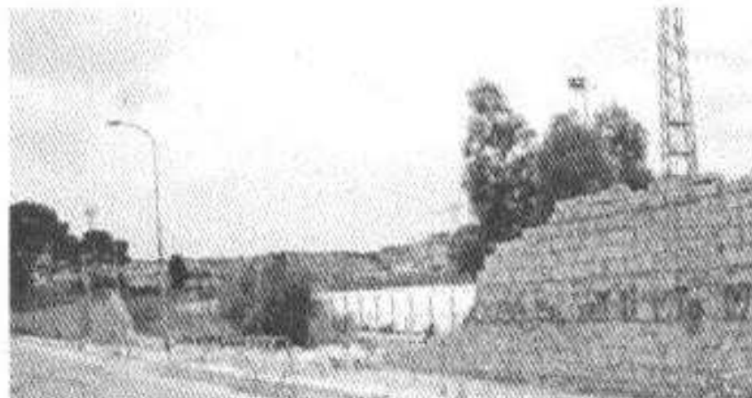
IL MURO CHE DELIMITA IL CAMPO SPORTIVO DI CONTRADA JUNGI
